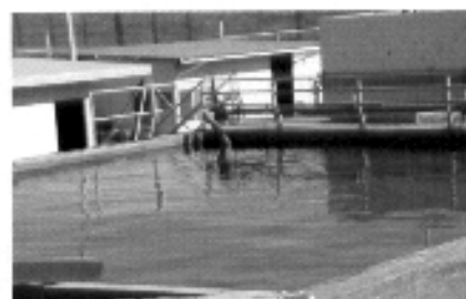
4. Reactor de sedimentación
